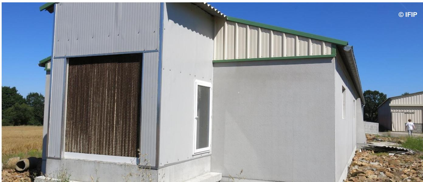
Refroidir l'air extérieur à l'entrée du bâtiment grâce à un cooling (généralement positionné au pied du mur pour faciliter les travaux d'entretien)
