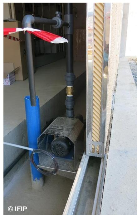
Humidifier un maillage plastique ou cartonné à l'aide d'une pompe, positionnée au sol, pour rafraîchir l'air chaud passant à travers
